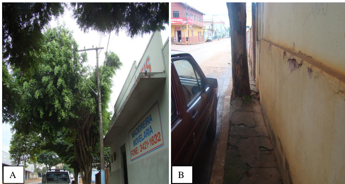
Figuras 5: Conflito com a rede elétrica e poste de iluminação(A), impedindo o trânsito de pedestres (B) na Avenida Josaphat Macedo, Luz/MG.
